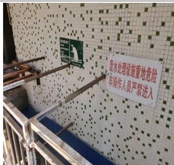
废水排放口标识牌
