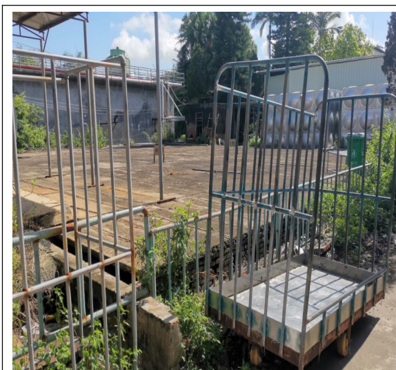
集水池及应急池
