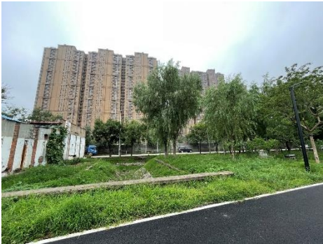
本项目东区现场照片
