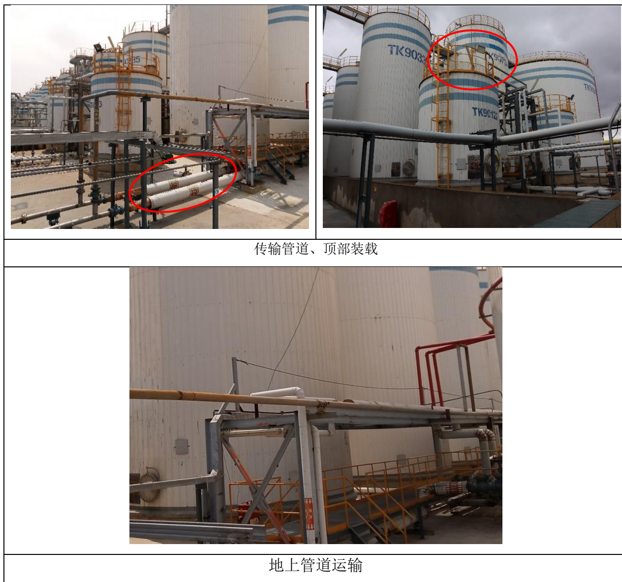
图 4.1-10 副产品罐区液体的转运与运输
