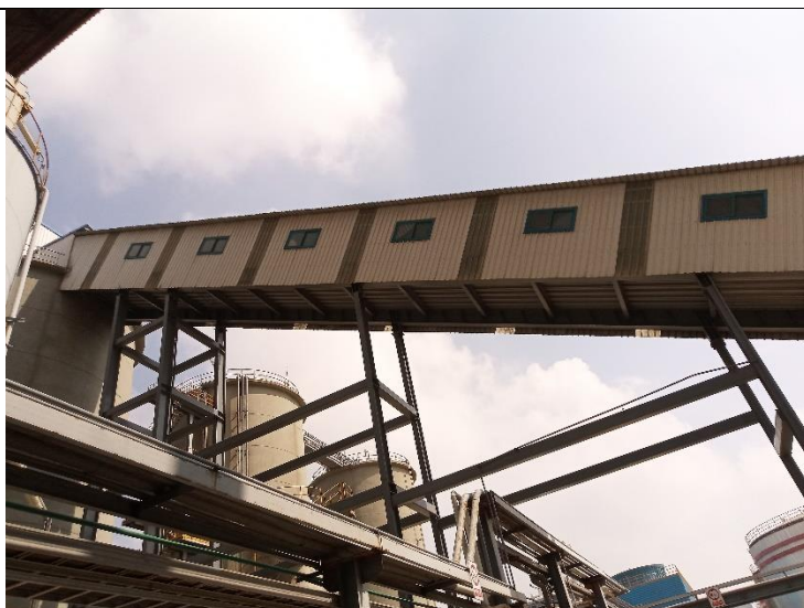
罐体、正压浓相气力输送系统、皮带输送机廊道无破损
