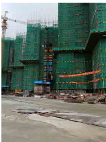
建筑物施工 2016 年 6 月 28 日
