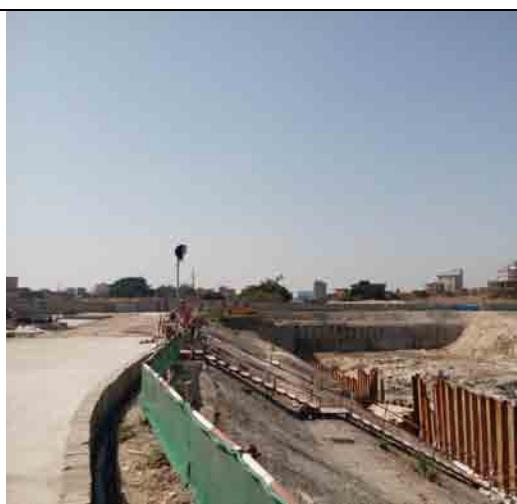
基坑防护 2014年2月28日
