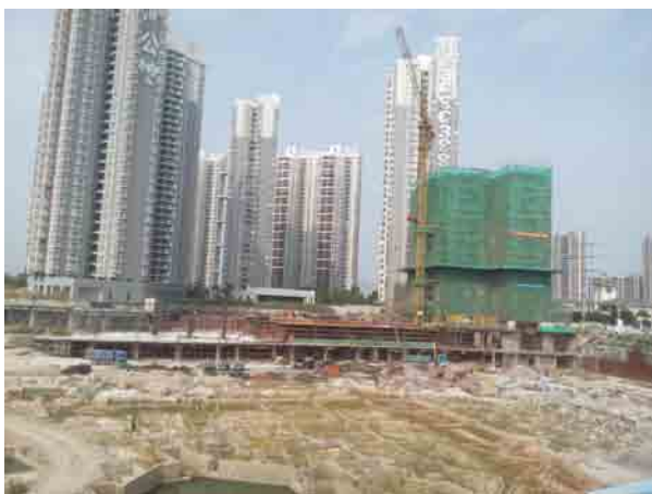
基坑施工现场 2014年9月28日
