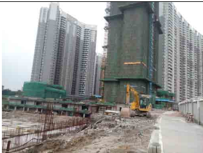
基坑东侧 2015 年 5 月 28 日
