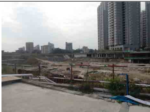
基坑外防护 2014年9月28日
