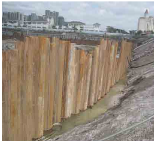
基坑边坡，2013 年 12 月 18 日
