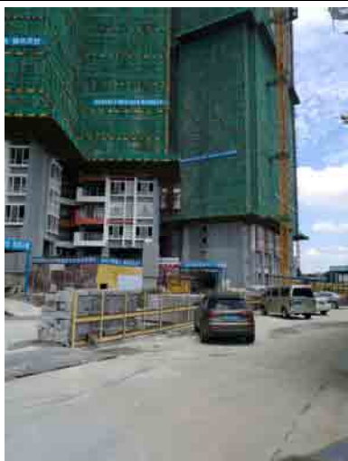
地上建筑施工 2016 年 9 月 28 日
