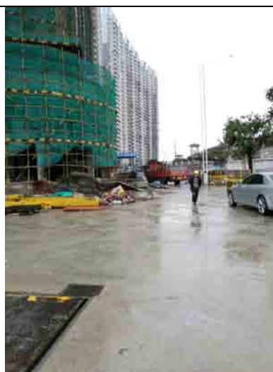
施工场地东面 2016 年 3 月 28 日
