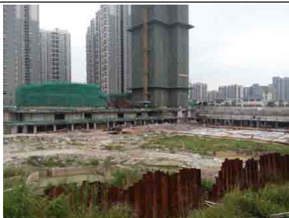
基坑施工 2015年5月28日
