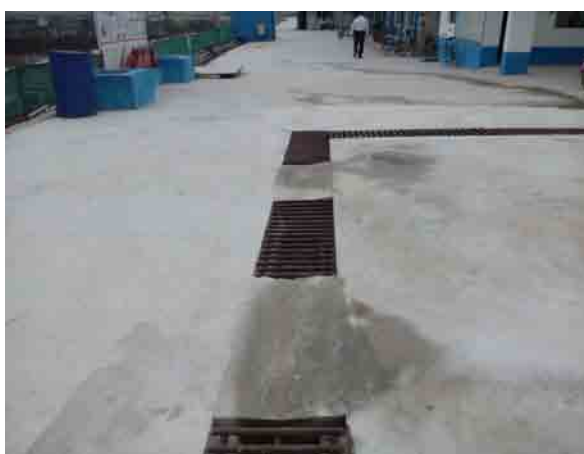
洗车槽 2014年5月28日
