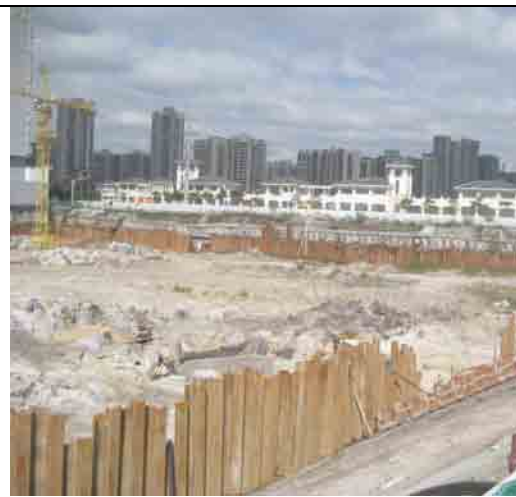
基坑施工，2013 年 12 月 18 日
