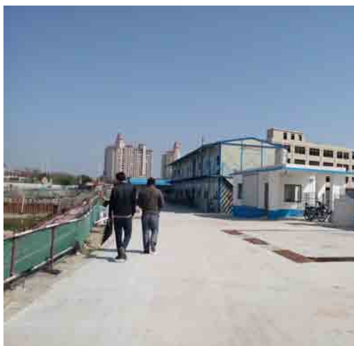
施工工区+洗车槽 2014年2月28日
