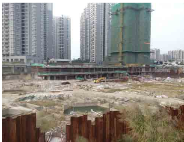
基坑施工 2014 年 9 月 28 日
