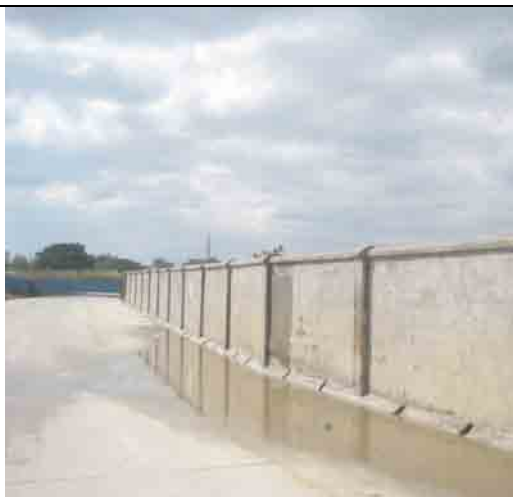
施工围墙 2013 年 12 月 18 日
