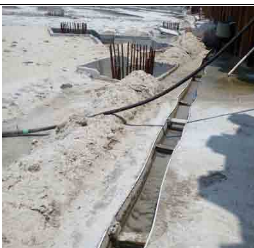
基坑排水沟 2014年2月28日
