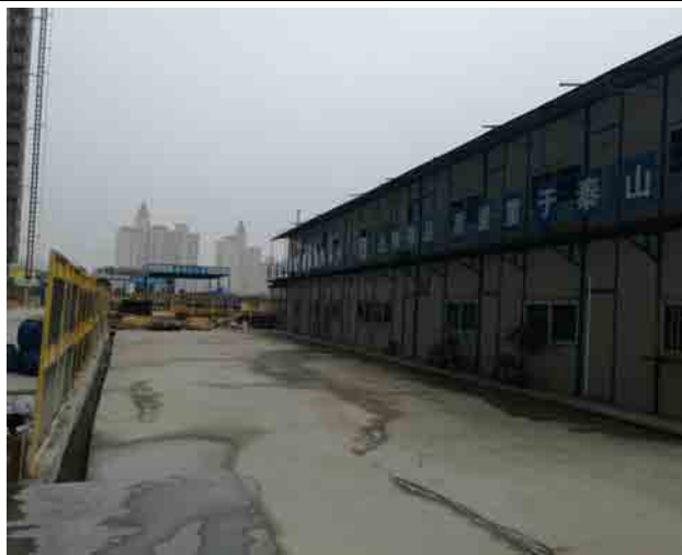
施工工区 2017年2月28日
