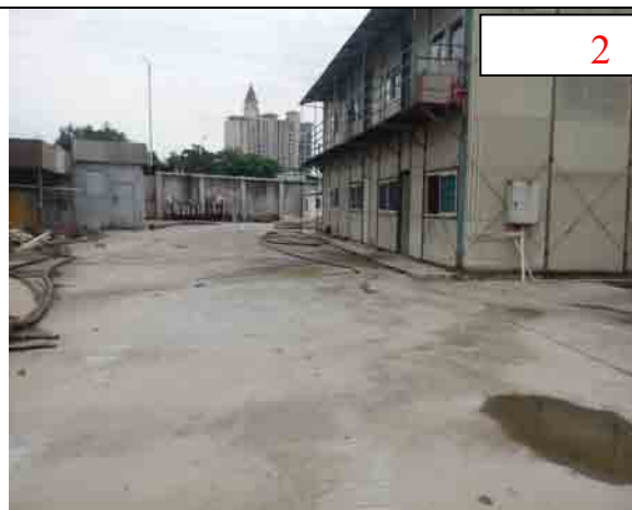
施工营地区 2015年5月28日
