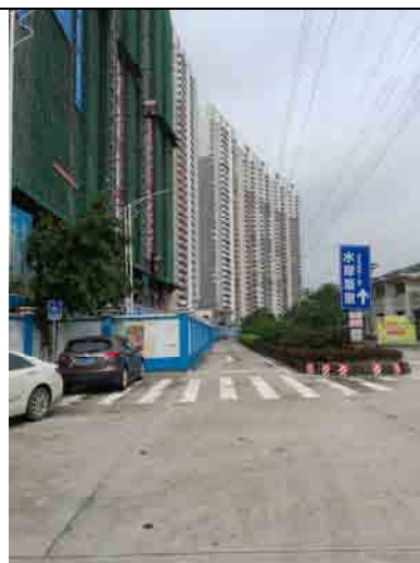
项目东侧外道路 2016 年 6 月 28 日
