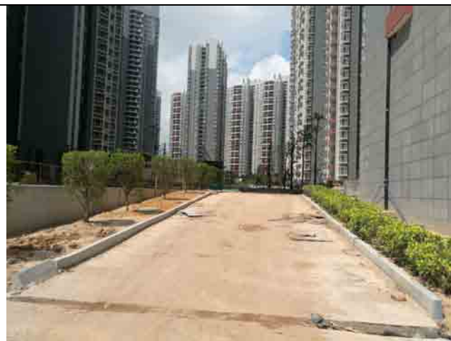
道路绿化施工 2017 年 9 月 28 日
