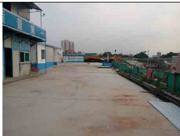
施工营造区 2014年6月28日
