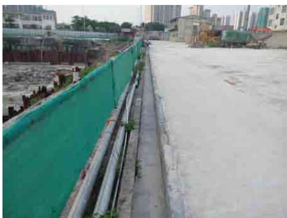
基坑顶排水沟 2014年6月28日
